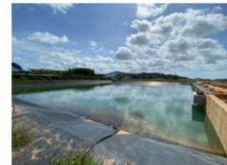
สระเก็บน้ำดิบสำหรับผลิตน้ำประปา (บ่อคอนกรีต) Water basin for supply (concrete basin)
