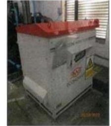
ถังกรองและเครื่องผลิตโอโซน Ozonation treatment
